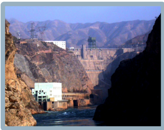
甘肃刘家峡水位监测系统
